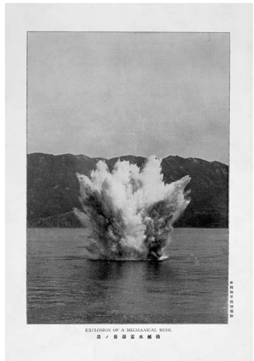
【図11】 市岡海軍技師撮影「機械水雷爆発ノ景」『日露戦役海軍写真帖 全』明治38年12月25日
