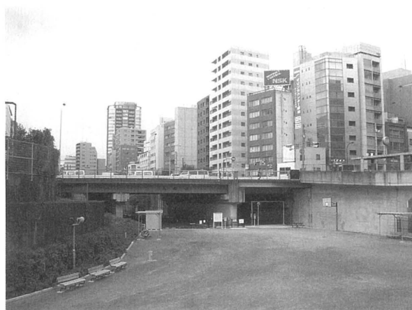
【写真4】 第4の橋 入船橋
