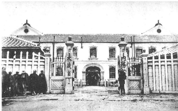
図2 大蔵省、内務省 林忠恕 明治5年(1872) [[明治大正建築写真聚覧』(日本建築学会 1936)より転載] (以下特記のないものは同じ)
