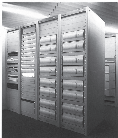
▲サービス映像室・CCTV 架・UPS(無停電電源装置) 架×2。
