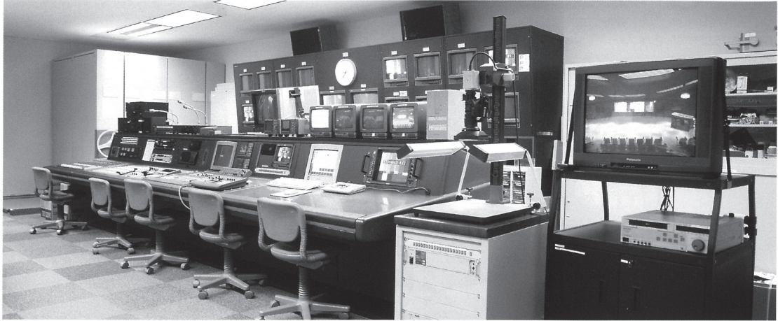
▲ AV 情報システムの中核となる AV センターと AV コントロール卓設備。 ▼ 写真右下は映像・音響機器架、左下は館内 CATV システムの自動送出装置とヘッドエンド装置。
