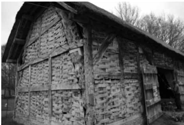
エイボンクロフト野外博物館 納屋の復元方法
