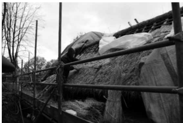
チルターン野外博物館 茅の葺き替えの様子
