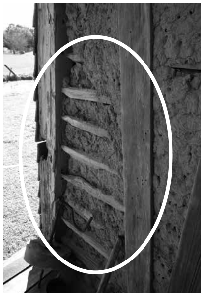
1-(3)-③-1a 土壁の土台を見せている。
