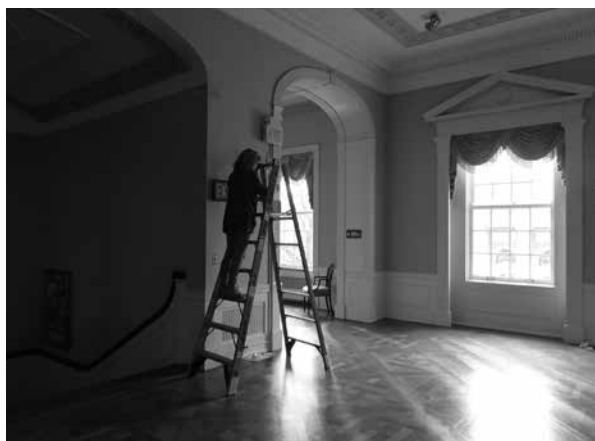
3-(4)-2a 階段付近修復作業
