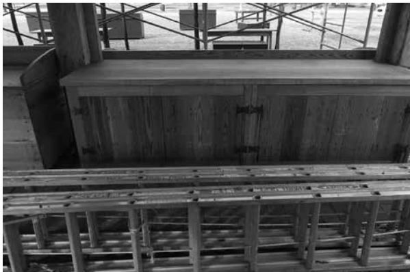
2-(3)-②c 市場復元工事現場
