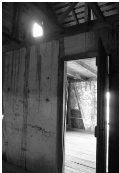
1-(3)-③-1c トラスの屋根、壁などアケイディアンの伝統を継いでいる。
