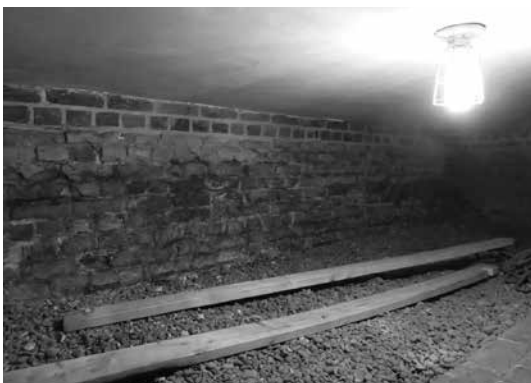
2-(3)-①d 基礎部分
