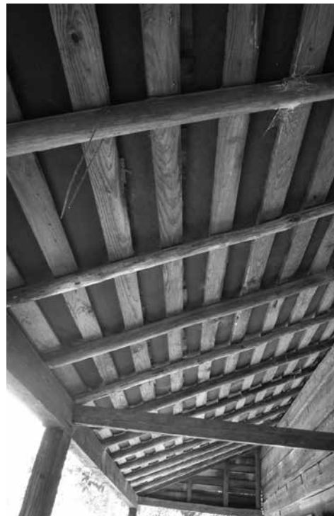
1-(3)-②-6b 屋根の防水シート
