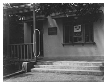
【図1-3】外壁改修後の陳列館外観
